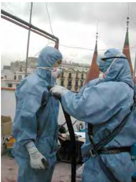
Figura 1. Aspiración previa a la descontaminación en cabina.
