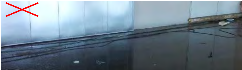
Tendido de conductores eléctricos en zona encharcada
