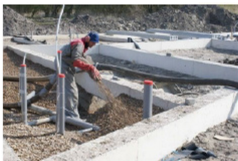
Figura 1: Aplicación de conchas como aislante
